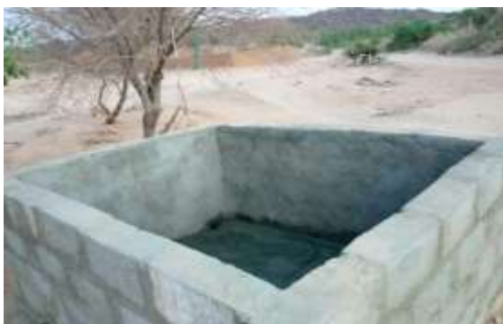
Bassin de stockage
