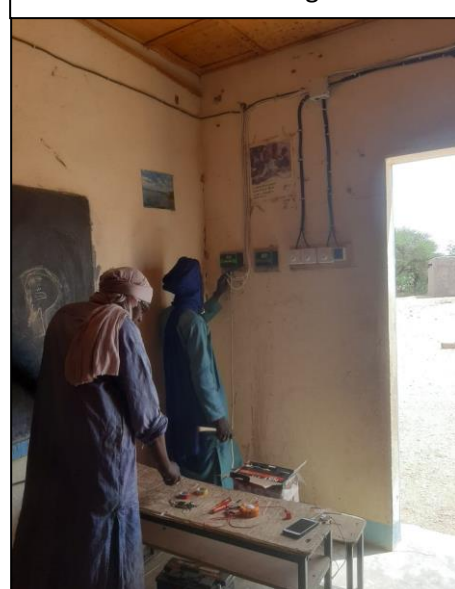
Installation de l'éclairage scolaire
